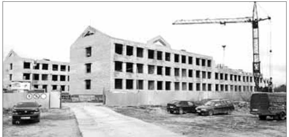
■ На Варавино строится школа на 860 мест
