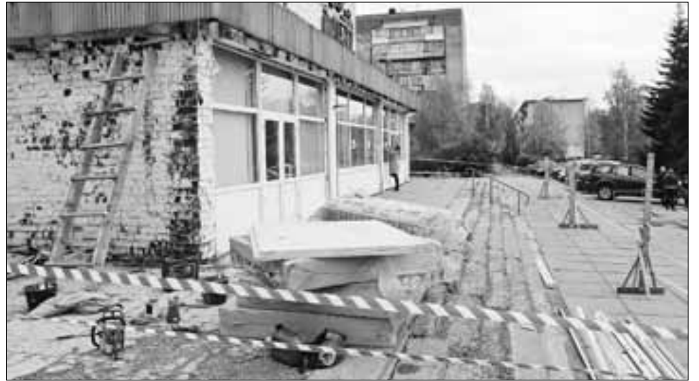
■ Масштабные работы проведены по ремонту крыльца Ломоносовского ДК.
